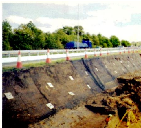
stabilizace svahu použitím kotev Duckbill
