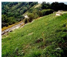
Ochrana svahov a brehov georohožami (typu Macmat®), ktoré sú počas výroby spevnené dvojzákrutovou oceľovou drôtenou sieťou.
