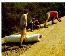
Kladenie protieróznej biorohože Biomat® na svah.
