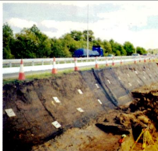
stabilizace svahu použitím kotev Duckbill
