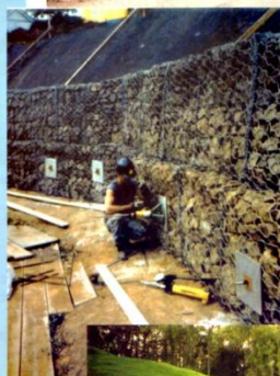
Nahoře - skryté Duckbill kotvy stabilizují amorfni opěrnou zeď
