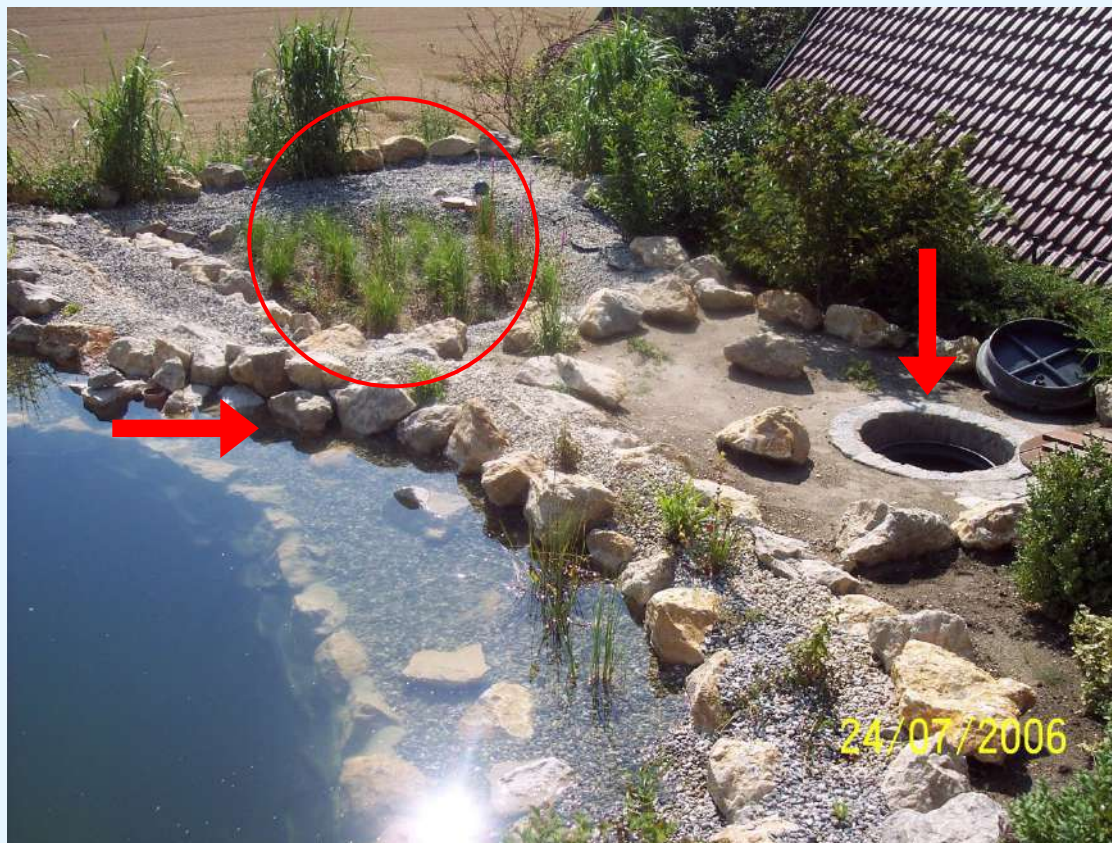
Přepad – půdní filtr - čerpací šachta
